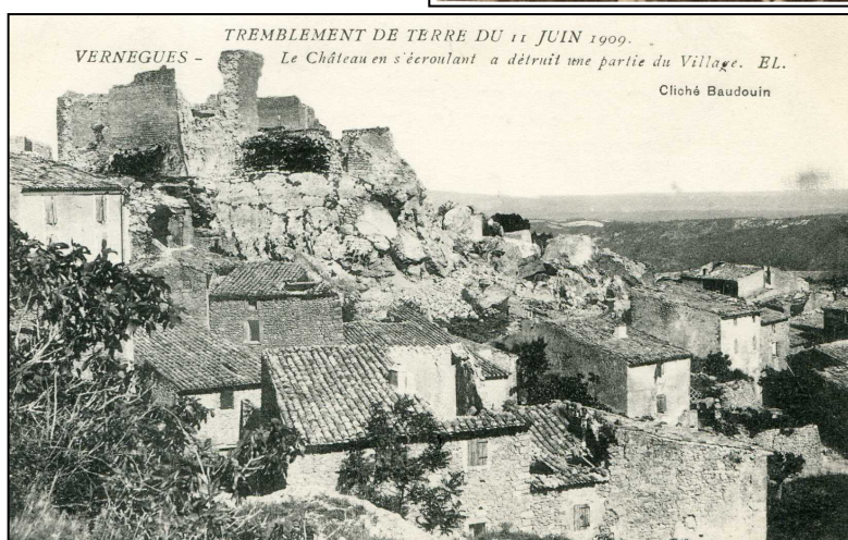
« TREMBLEMENT DE TERRE DU 11 JUIN 1909 – VERNEGUES – Le château s'écroulant a détruit une partie du village »
